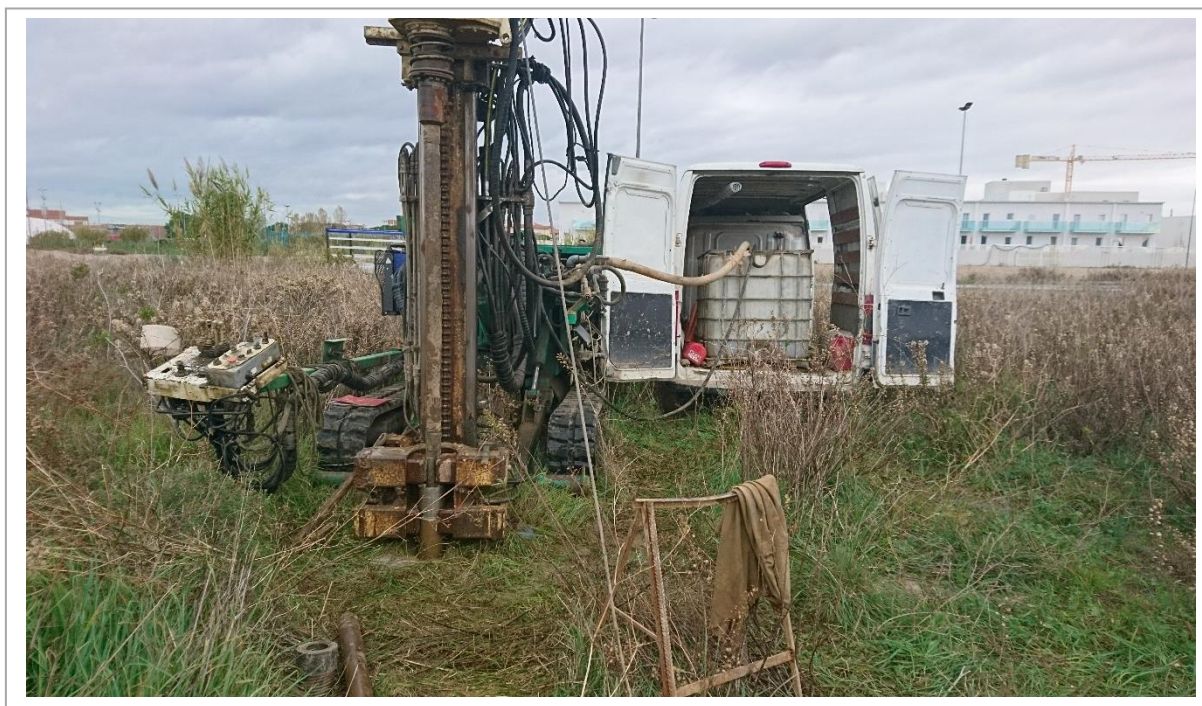
Figura 12 – Esecuzione sondaggio S1 con impianto IPS DRILL 650
